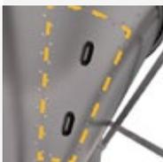
**Puerta de Acceso para Limpieza**: permite una mejor higienización del Silo, de forma rápida y segura. Producida en chapa zincada con mayor durabilidad. Amplia abertura de acceso. Gomas en todo el perímetro, garantizando un perfecto sellado.
