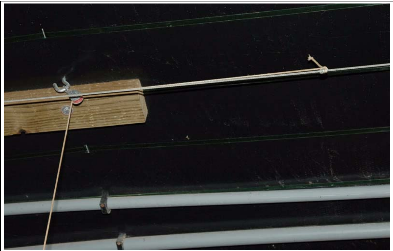
Рисунок 5С Крюк с винтом и шкив подвесного шнура
